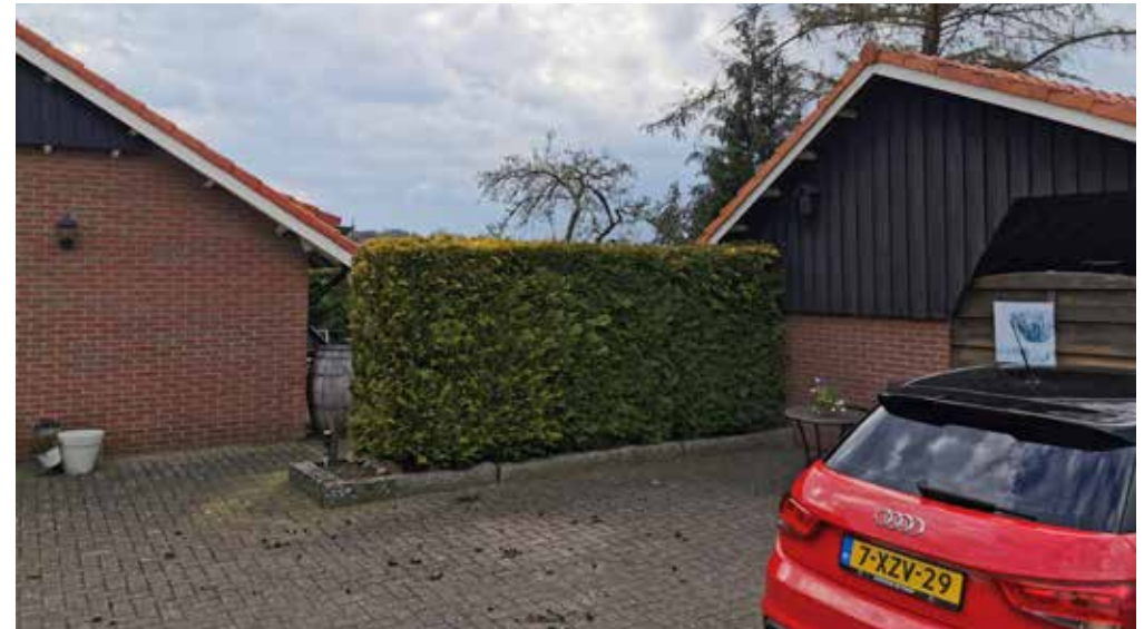
Figuur 2. Achter op het erf worden de 3 vakantieappartementen gerealiseerd.
