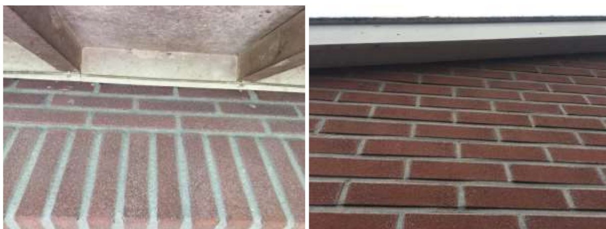
De betimmering van de overstek van het dak sluit naadloos aan op de buitengevels
