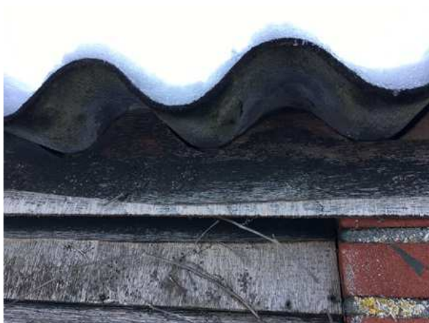
Afdichting van de openingen onder de golfplaten. Op deze wijze kunnen vogels en grondgebonden zoogdieren, zoals bruine rat en steenmarter, de holle ruimte tussen golfplaat en dakisolatie niet betreden.
