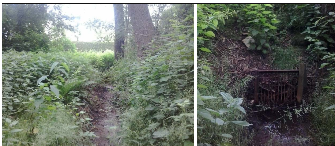
Figuur 4.2 Naar het riool afvoerende watergang locatie Krabbendijk
