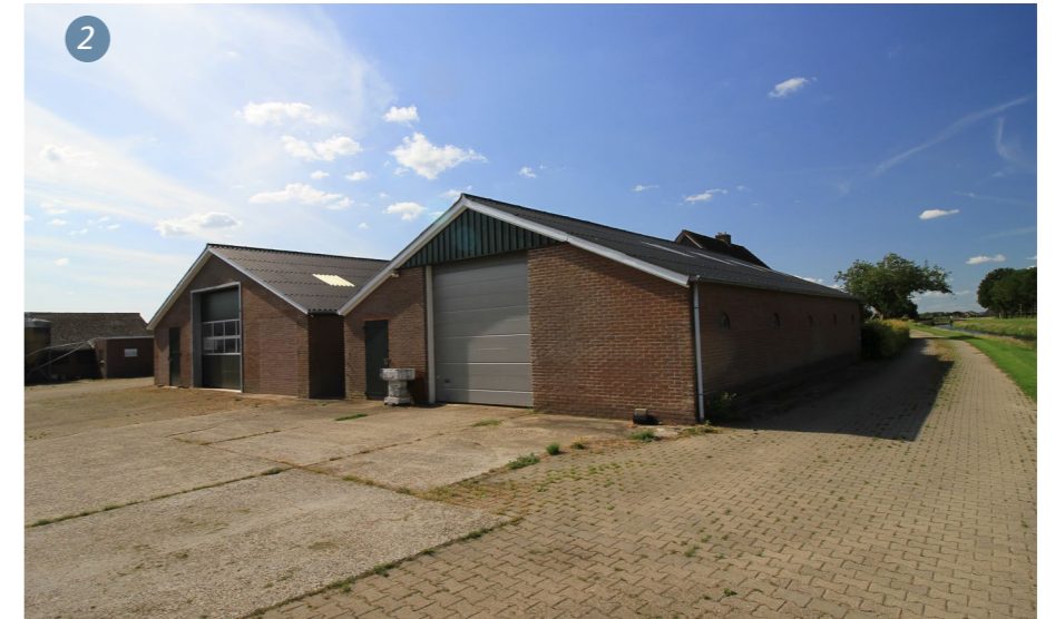
Te behouden bijgebouwen gelegen achter het bestaande woonhuis
