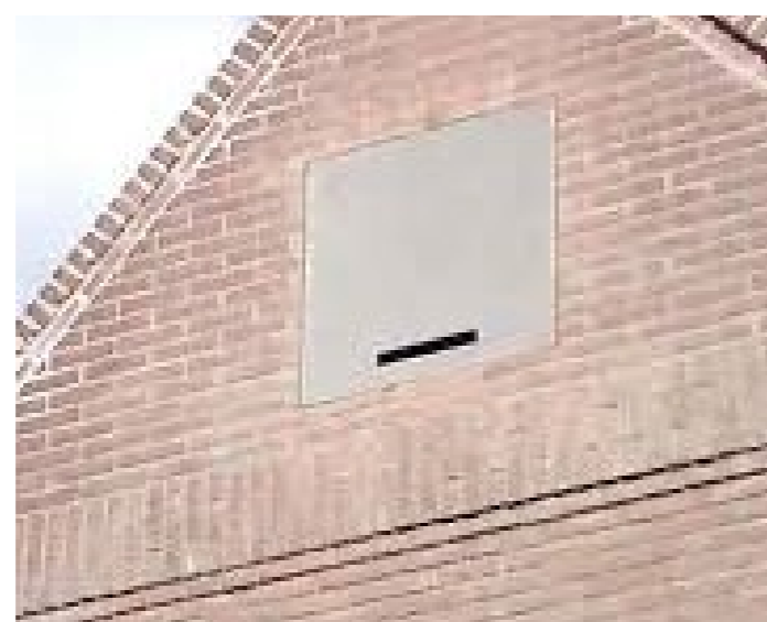
Vleermuiskast in gevel
