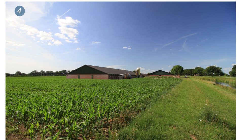
Achteraanzicht te slopen bedrijfsgebouwen
