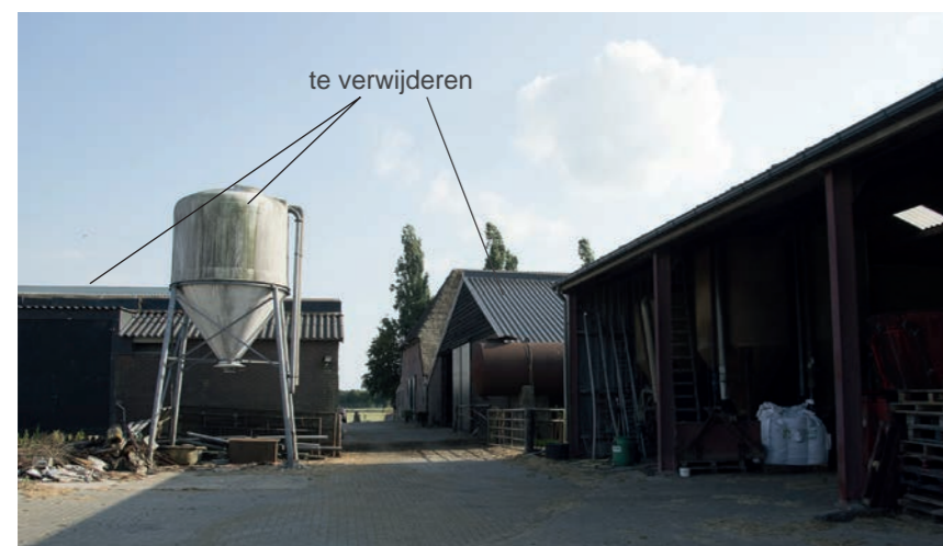
Afbeelding 2. Op het erf staan naast de woonboerderij verschillende schuren en bouwwerken. De meeste schuren zullen bij de herontwikkeling worden verwijderd.
