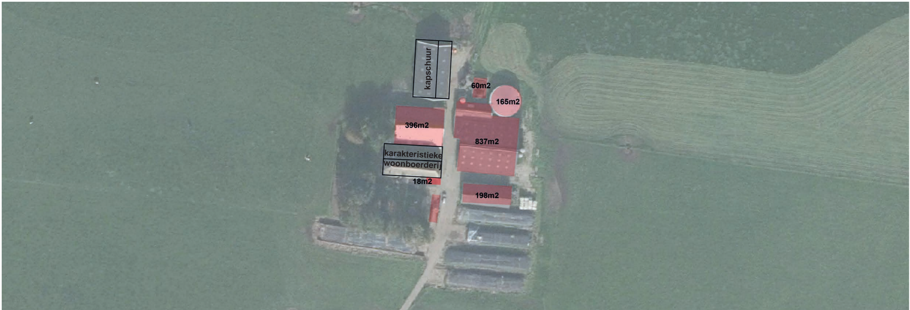
Afbeelding 8. Luchtfoto met daarop de te slopen gebouwen en daarbij horende oppervlakten. Het totaal te slopen oppervlak betreft 1674 m2.
