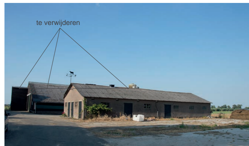
Afbeelding 5. Schuren aan de oostzijde van het erf, allen zullen worden gesloopt.
