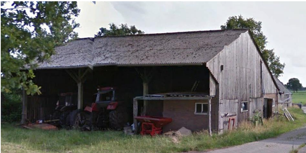
Figuur 4, te slopen kapschuur
