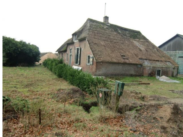
Bestaande boerderij, slopen en nieuwbouw
