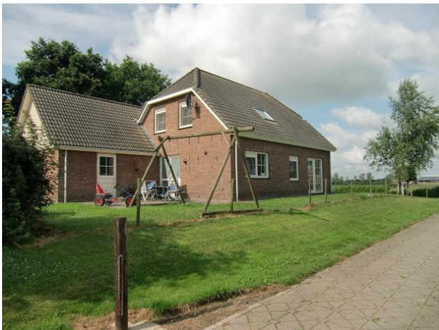
Bestaande woning aan de noordzijde
