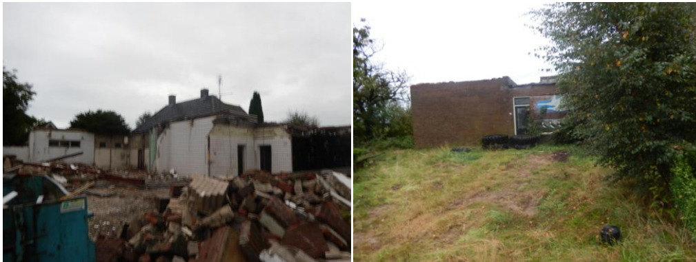
Figuur 1: enkele foto's van het plangebied, de bestaande bebouwing binnen het plangebied is reeds gesloopt.
