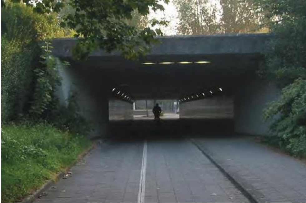
Fietstunnel (Bron: Wooninc e.a., 2010)
