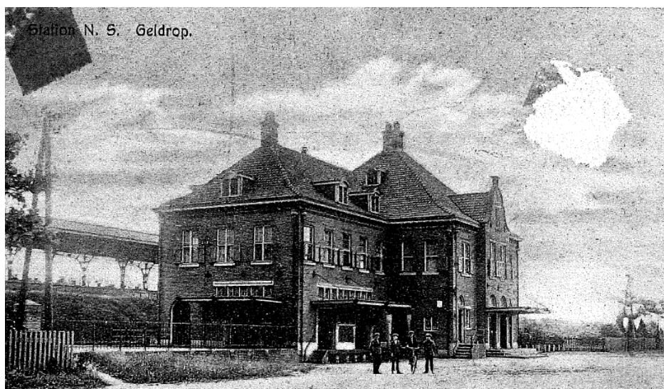
Afbeelding: oude treinstation in Geldrop
