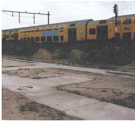
Alle verzwaarde funderingsloven zijn gekoppeld tot een geheel.
