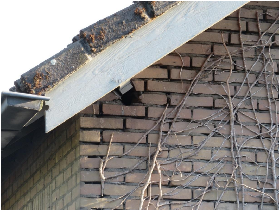
Gat onder de gording van 103. Aan de tegenoverliggende zijde bevindt zich een groter gat, zie §5.1
