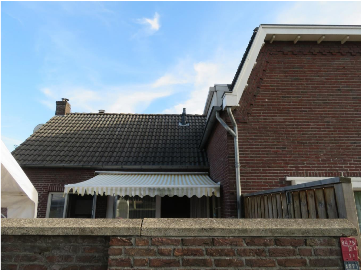
Gedeeltelijke zijgevel en dak 85. 87 is identiek aan 85.
