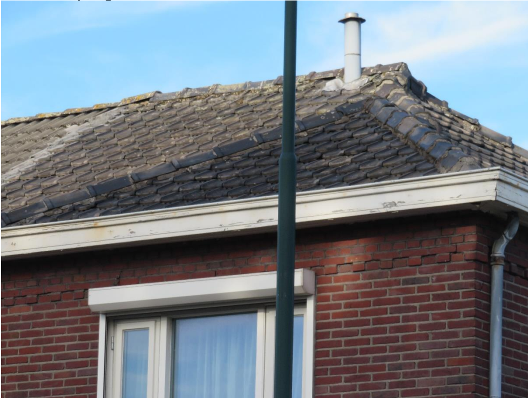
Nauw aansluitende pannen en vastgemetselde kant- en nokpannen op het dak van 85 en 87.
