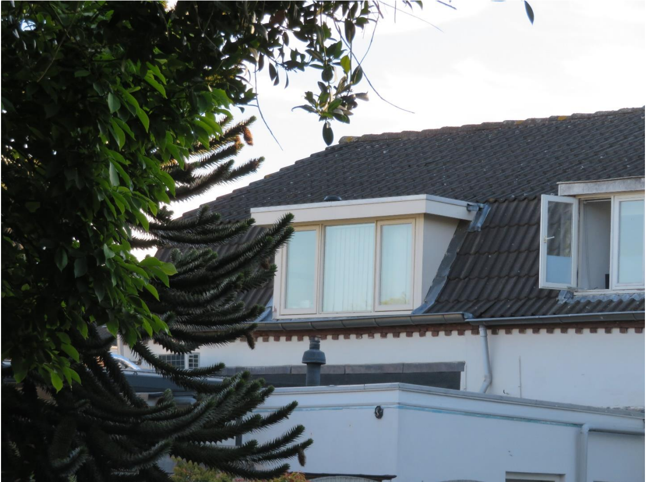
De dakpannen, loodslabben en het timmerwerk van de woningen 107 t/m 111 bevatten geen ruimtes die geschikt zijn voor vleermuizen.
