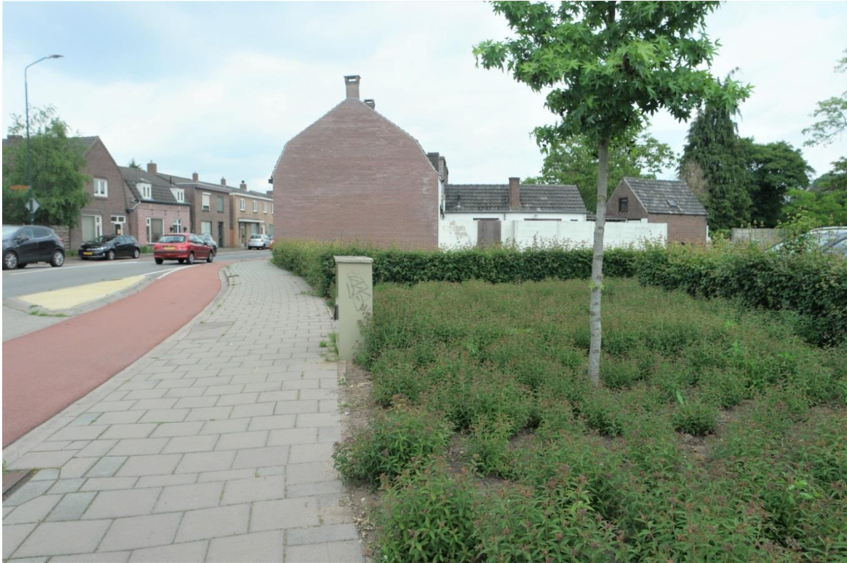
De kruising met de Beukelaar is gereconstrueerd. Naast de kruising bevinden zich een groenstrook en een parkeerplaats.
