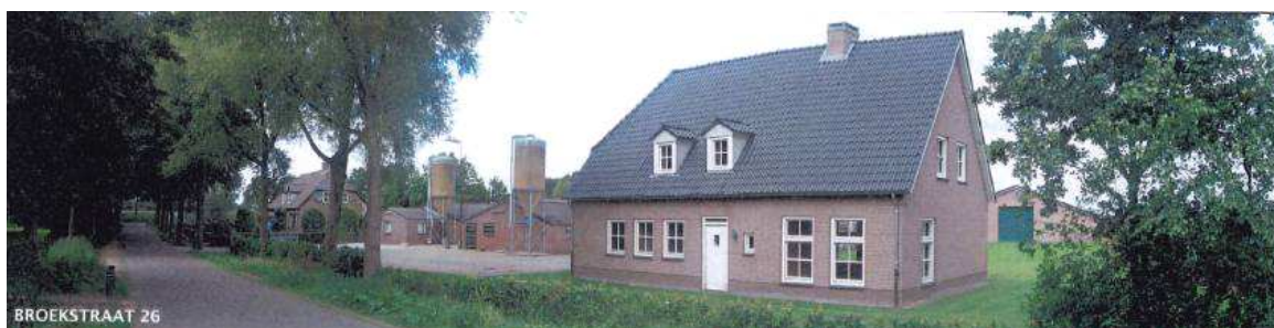
Figuur 17. Bedrijfswoning aan de Broekstraat 26 met op de achtergrond de bedrijfsbebouwing op de plangebied.
