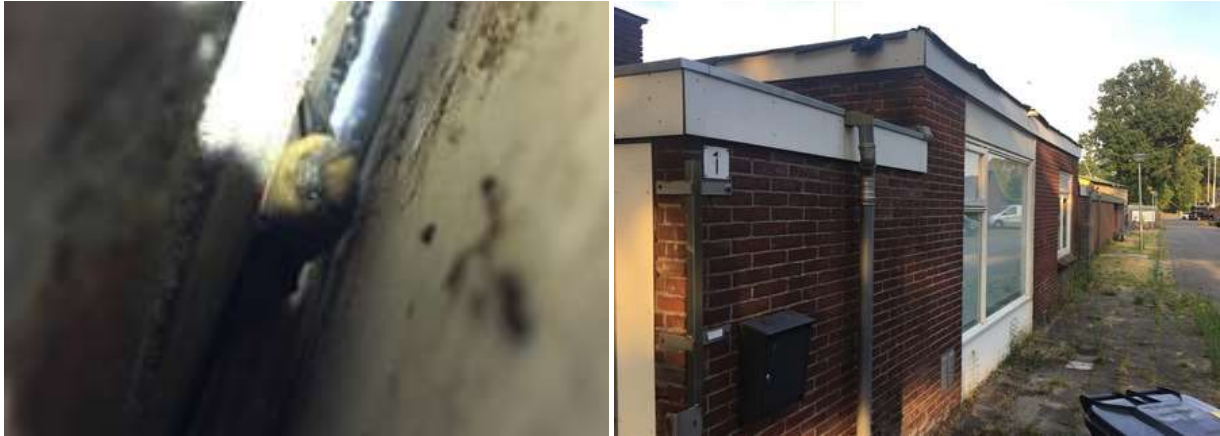
Foto links: gewone dwergvleermuis achter boeiboord. Foto rechts: zicht op de verblijfplaats.
