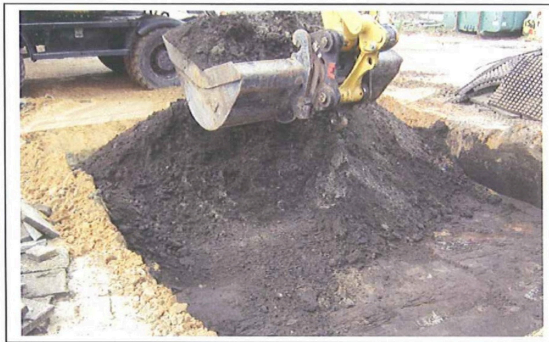
Ontgraven verontreinigde laag
