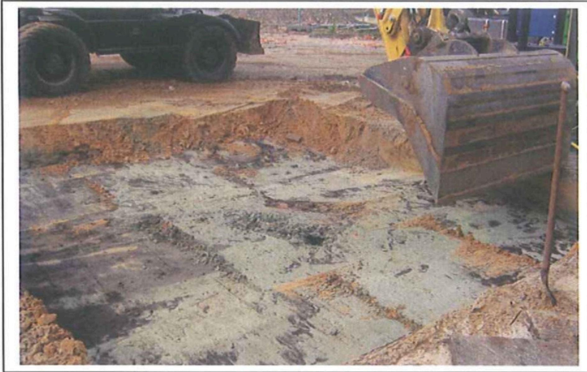
Separaat ontgraven cunetzand
