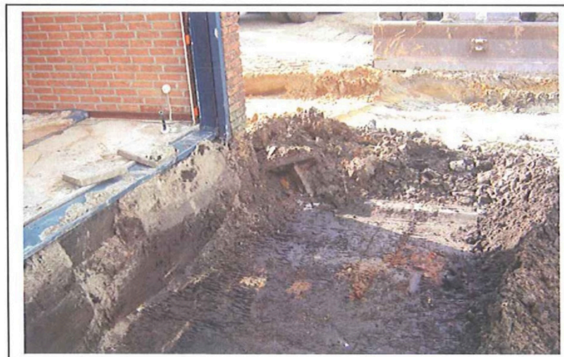
Ontgraving spot hoek voormalig schoolgebouw
