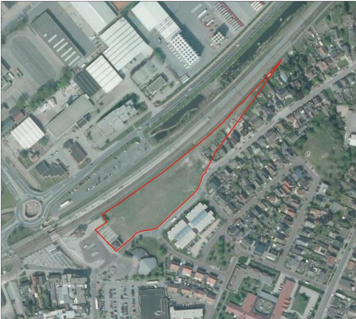
Afbeelding 2.3: Luchtfoto huidige situatie plangebied (Bron: Provincie Overijssel)
