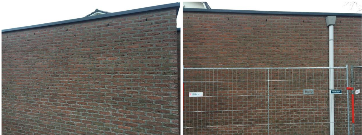
Open stootvoegen in de buitengevels van de bebouwing.
