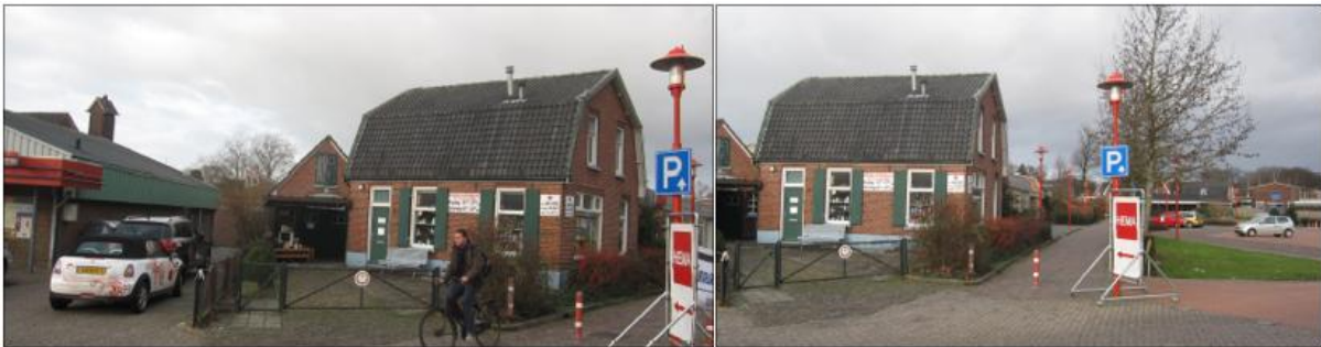
Afbeelding 2.4: Bebouwing ter hoogte van het Zwartepad (Bron: BDC architecten)
