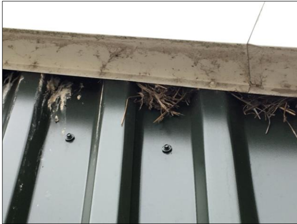
Foto boven: nesten van spreeuwen onder de golfplaten van de te slopen varkensstallen.
