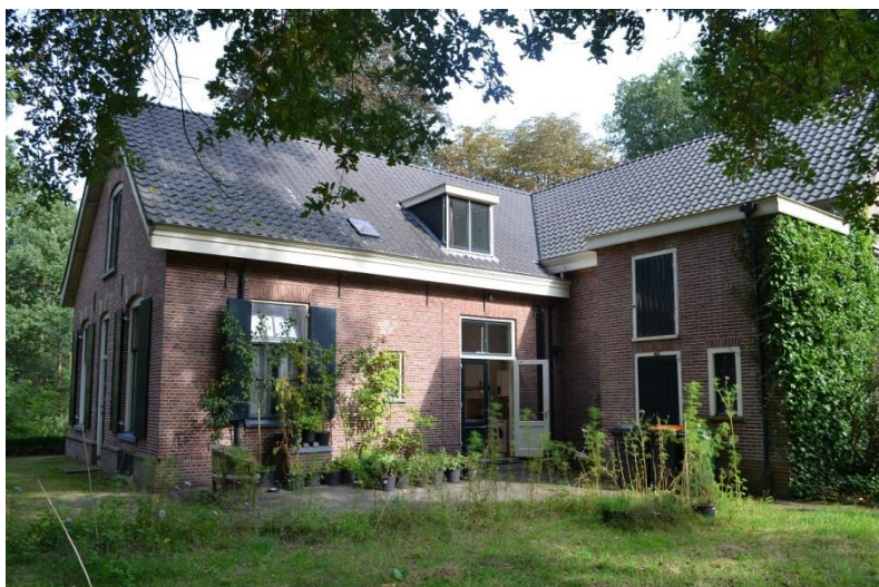
Afb. Achterzijde van het pand met links het woongedeelte
