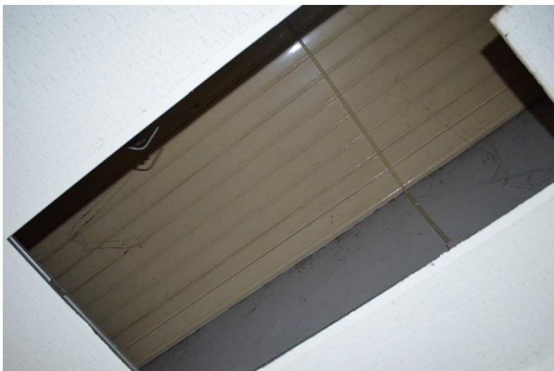
Afb. Kraaldelen verscholen achter het verlaagde plafond
