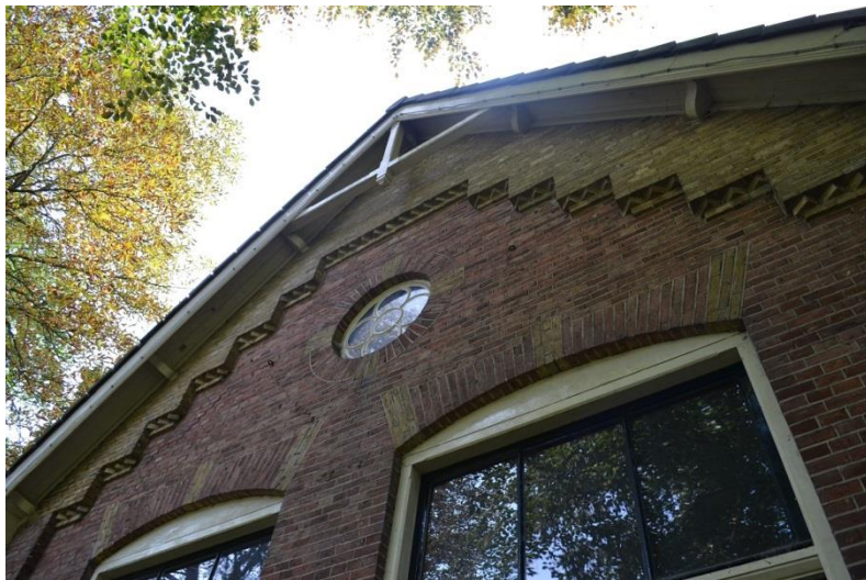
Afb. Fraai uitgemetselde topgevel met muizetand en makelaar als afsluiting onder de nok
