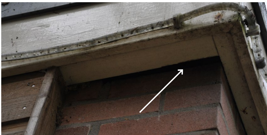
Toegang tot ruimte tussen dak en dakbeschot/tot ruimte in spouwmuur.
