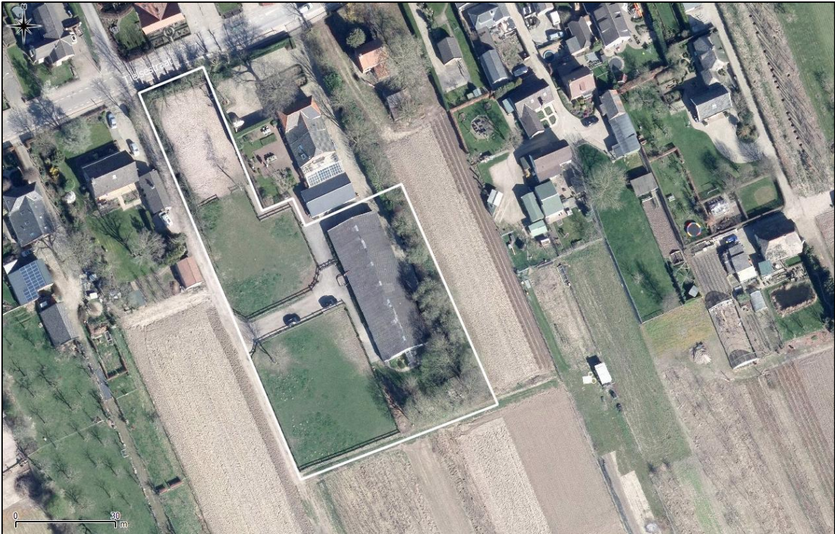
Figuur 2. Luchtfoto onderzoekslocatie en directe omgeving. De witte lijn geeft de onderzoekslocatie aan.
