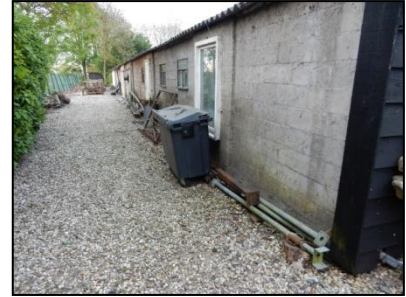
Figuur 11. Buitenzijde schuur
