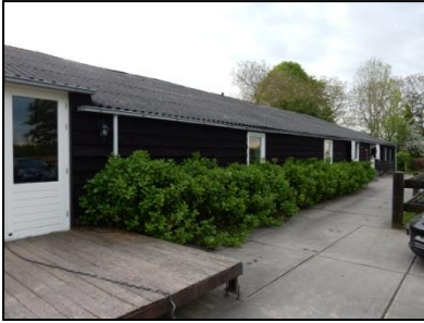
Figuur 9. Buitenzijde schuur
