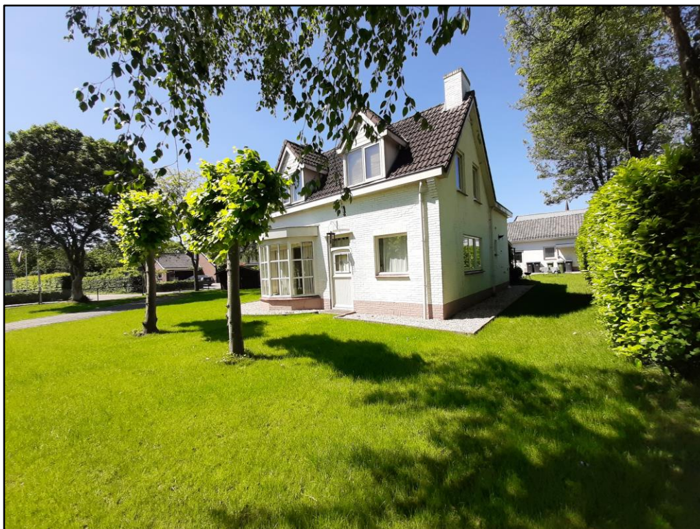
Figuur 2 De te behouden woning op het noordelijke deel van het perceel.
