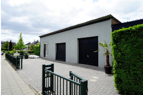
Het te amoveren bijgebouw.
