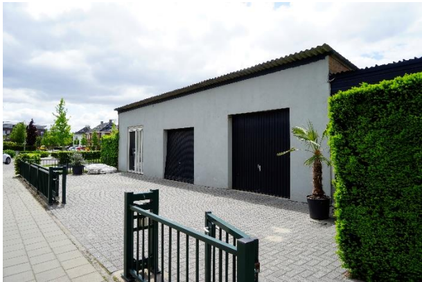
Het te amoveren bijgebouw.
