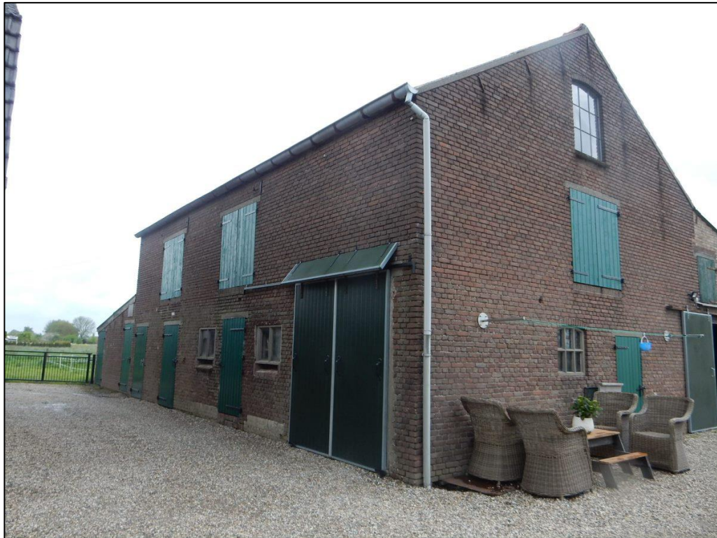
Figuur 1 Schuur 1 (zuidwestzijde). Deze schuur zal gesaneerd worden.
