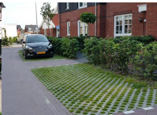
Parkeerplaatsen in halfverharding
