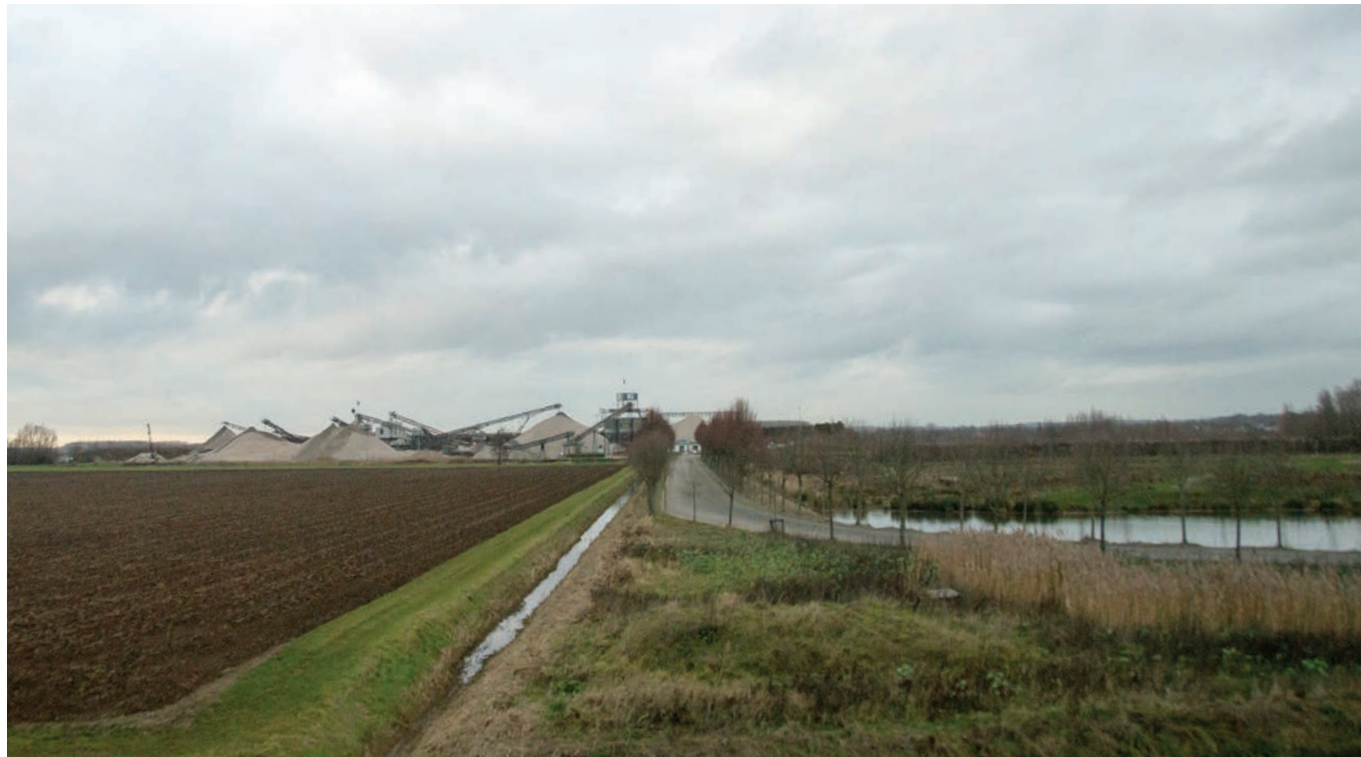
Afbeelding 5. Kijkend vanaf op- en afrit 34 richting de zandwinning K3Delta en de oostzijde van het plangebied.
