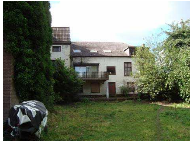
Foto 4. Westzijde plangebied met achterzijde meubelzaak.
