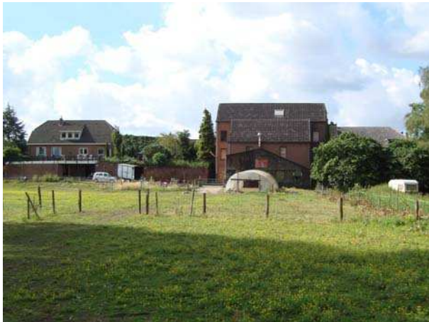
Foto 3. Achterzijde plangebied met links de woning en rechts het nieuwere gedeelte van de meubelzaak.
