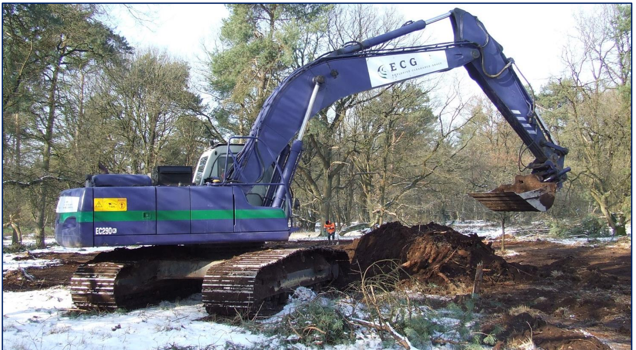
Figuur 3: Gecontroleerd ontgraven.
