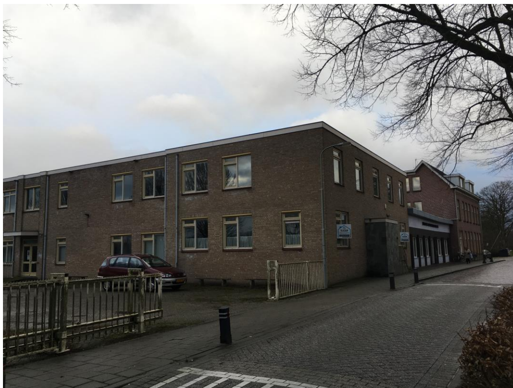
Figuur 1 Op het plangebied is een pand gevestigd dat in het verleden heeft dienstgedaan als kantoorgebouw.
