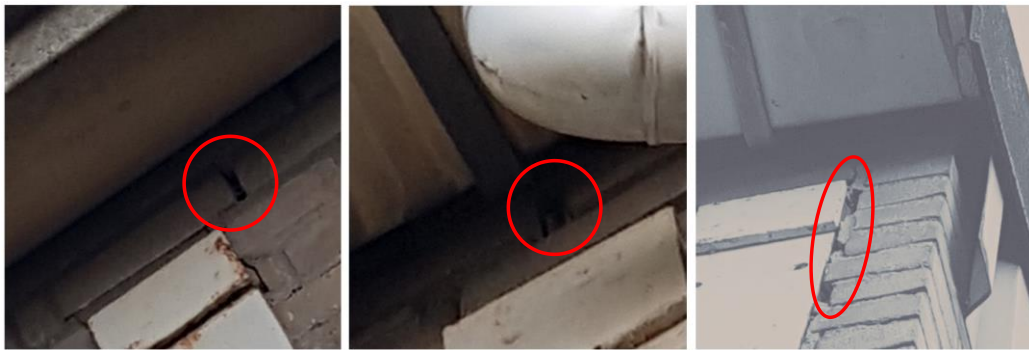
Figuur 3 De spouwmuur van de oostelijke loods op de planlocatie is op meerdere plaatsen door met name open stootvoegen toegankelijk voor gebouwbewonende vleermuizen.
