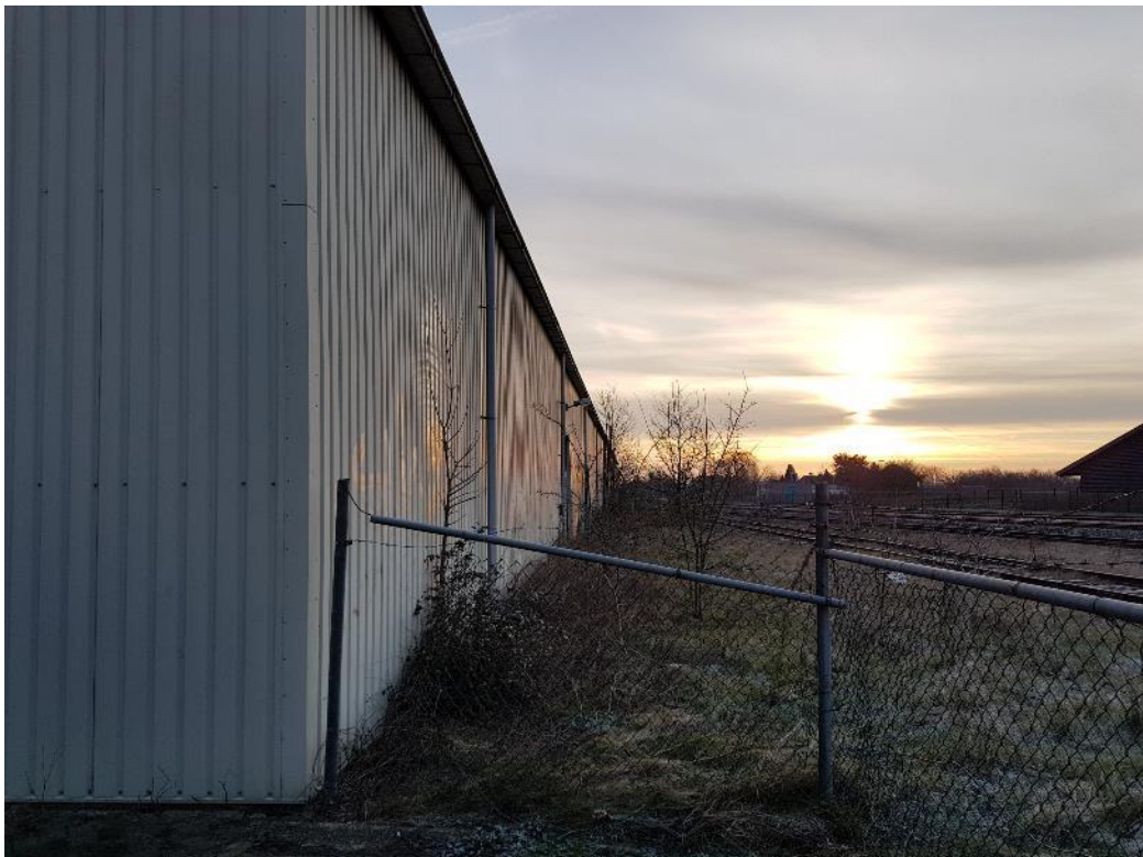
Figuur 4 Aan de zuidzijde grenst de planlocatie aan de spoorrails tussen Tiel en Nijmegen.
