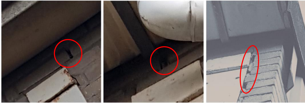
Figuur 2 Potentie van de bebouwing voor vleermuizen ten tijde van de visuele inspectie (bron: Blom Ecologie B.V.)
