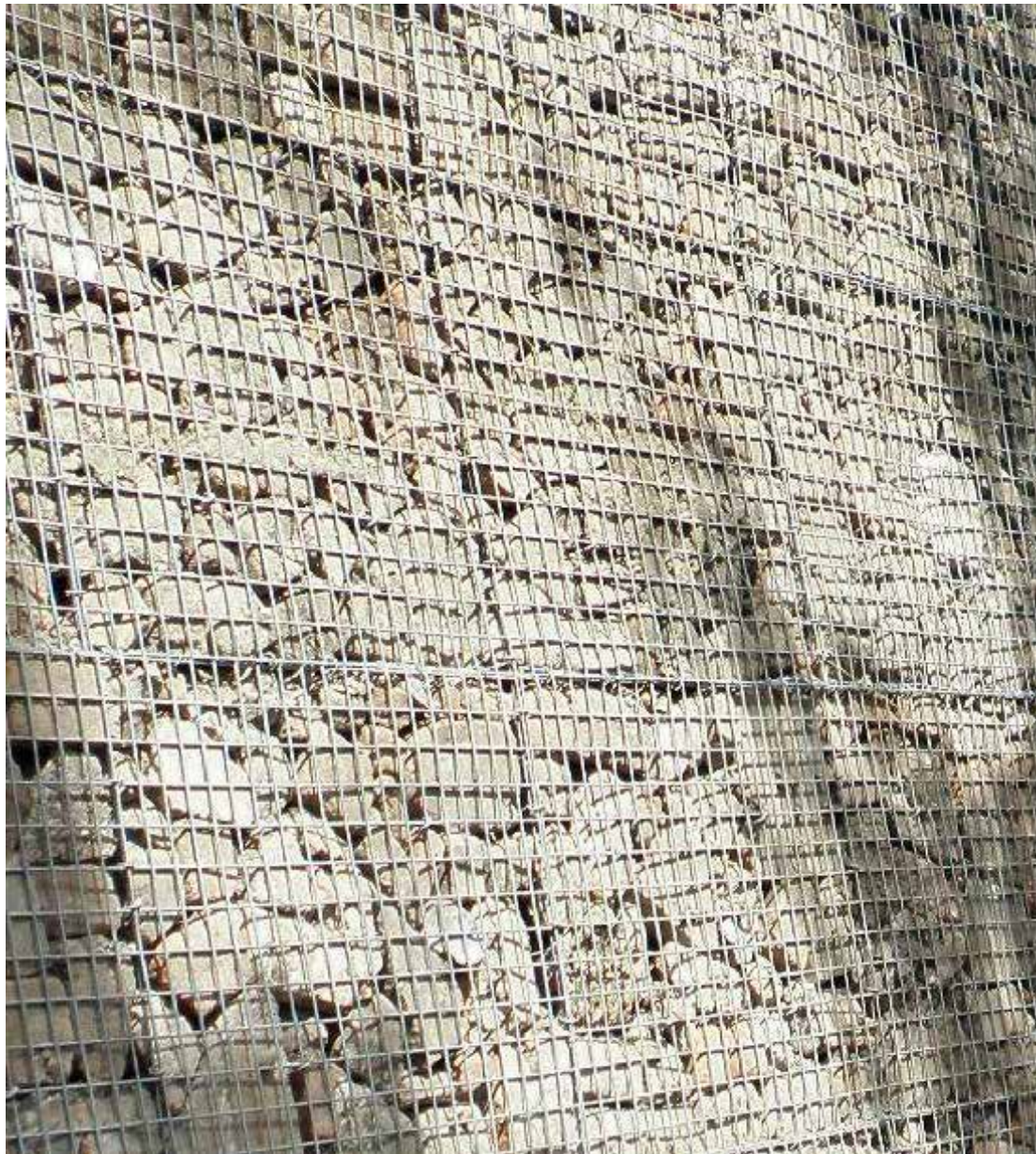
Referentiebeeld: Schanskorf (gebroken gerecycled puin)
