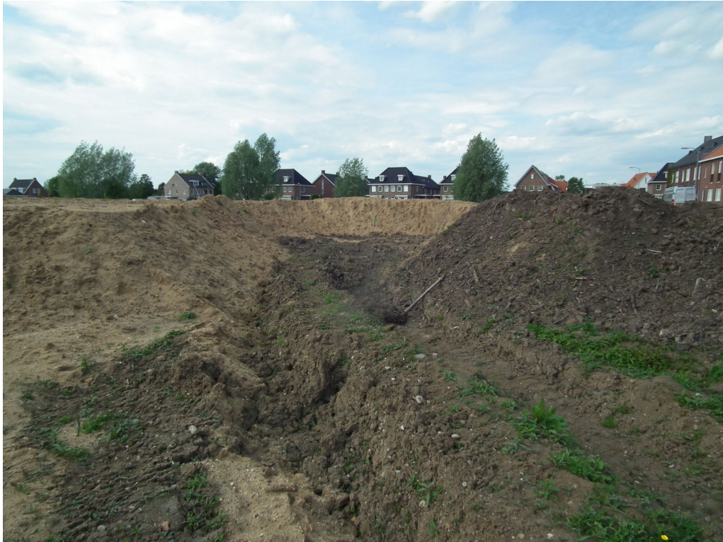
Figuur 5 Op perceel 3 bevinden zich grond- en zandhopen. Hier zijn voorbereidende werkzaamheden voor de ontwikkeling aan de gang.
