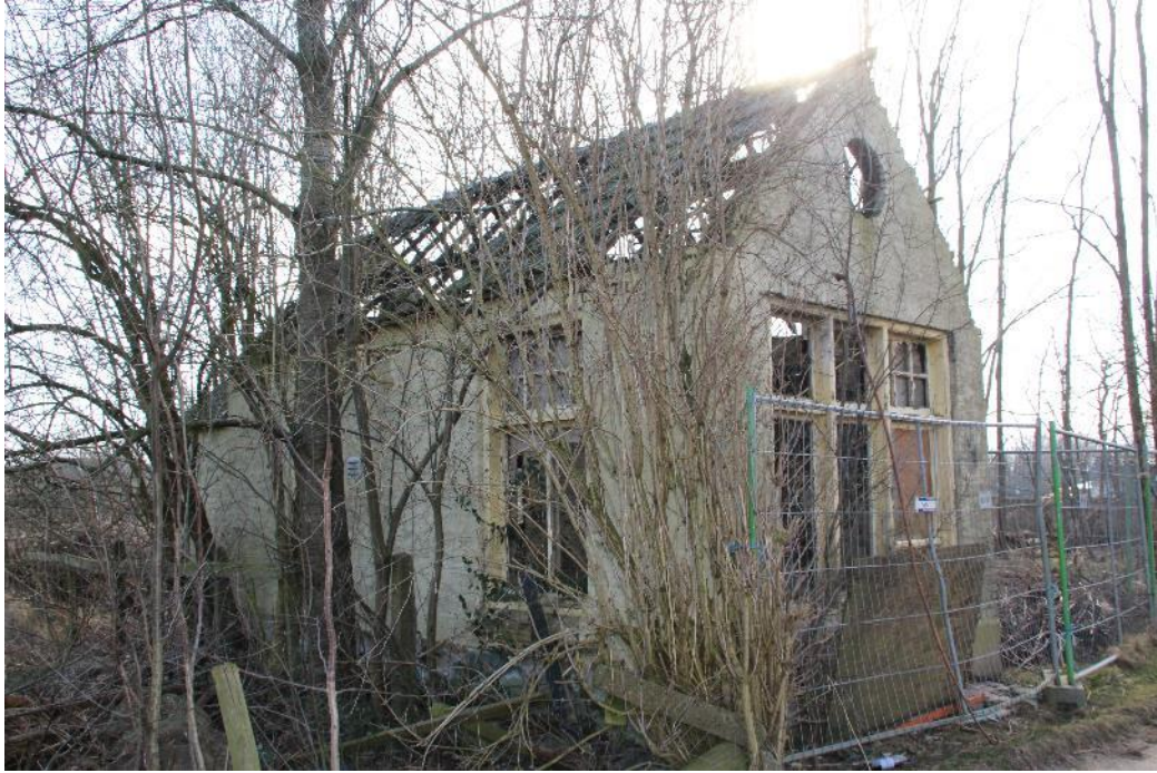
Figuur 7 Woning aan Matensestraat 49. De woning is geheel vervallen.
