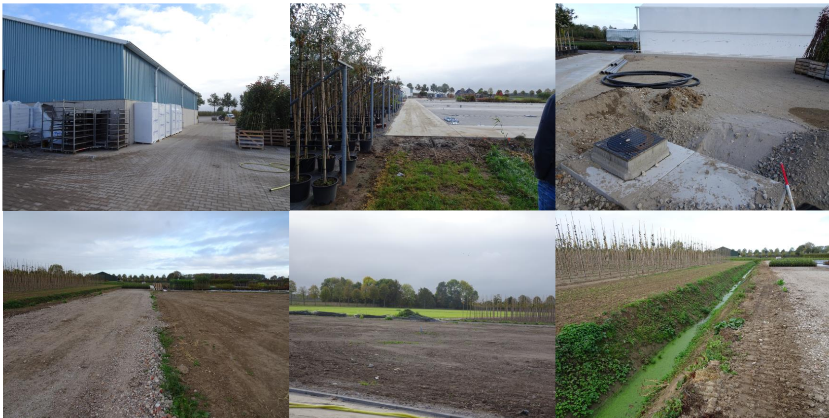
Plangebied met nieuwe betonnen opslag voor containerplanten, riolering, nieuw gegraven sloot, pad met menggranulaat en geëgaliseerde ondergrond voor nieuw te bouwen kas (foto's Laneco).
