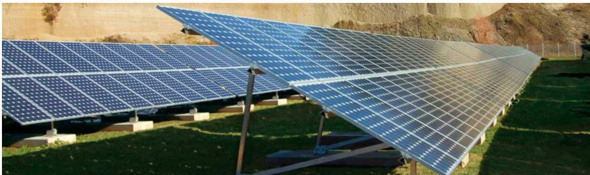
Afbeelding 16: Voorbeeld onderconstructie met betonvoeten
