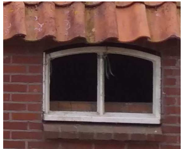
• Detailoverzicht betonnen stalraam, 2-vaks getoogd
