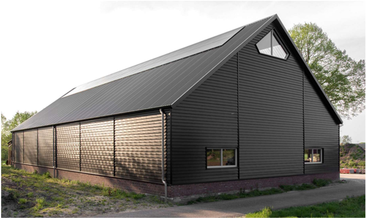
Bedrijfshal /veldschuur uitgevoerd in antraciet potdekselwerk, antraciet dak met zonnepanelen en witte raamkozijnen.
