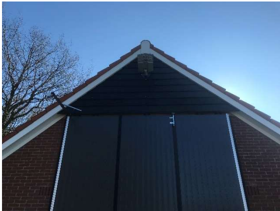
Antraciet vouwdeur en potdekselwerk in topgevel.
