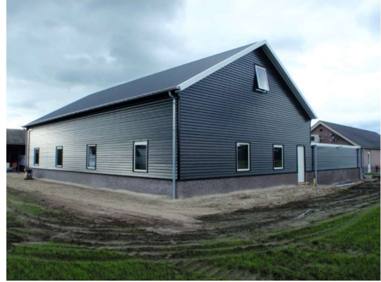
Bedrijfshal/veldschuur uitgevoerd in antraciet potdekselwerk, antraciet dak en witte raamkozijnen. Witte overheaddeur niet gewenst.
