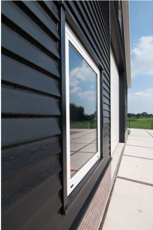
Details van gevel met antraciet potdekselwerk i.c.m. wit raamkozijn.
