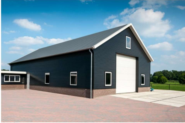
Bedrijfshal/veldschuur uitgevoerd in antraciet potdekselwerk, antraciet dak en witte raamkozijnen. Witte overheaddeur niet gewenst.
