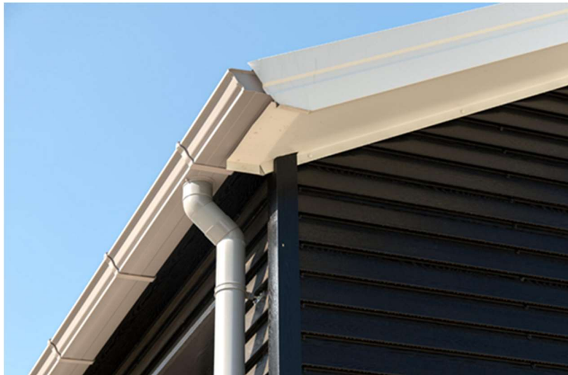
Detail van bakgoot met witte boei-delen en antraciet potdekselwerk gevels.
