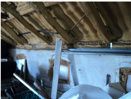
De schuur is geïsoleerd door middel van purschuim waar ook een deel van de ramen mee is dichtgezet.
