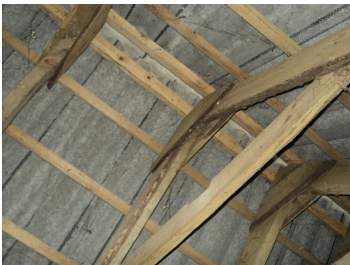
Op de zoldering bestaat het dak uit een houtconstructie met golfplaten.
