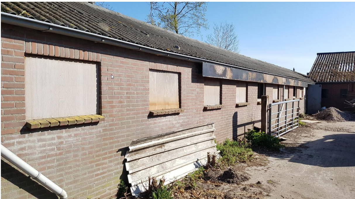
Bijlage 4: Buitenkant te slopen stal.
