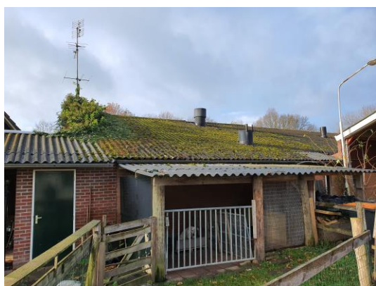
afdak golfplaten asbestvrij
