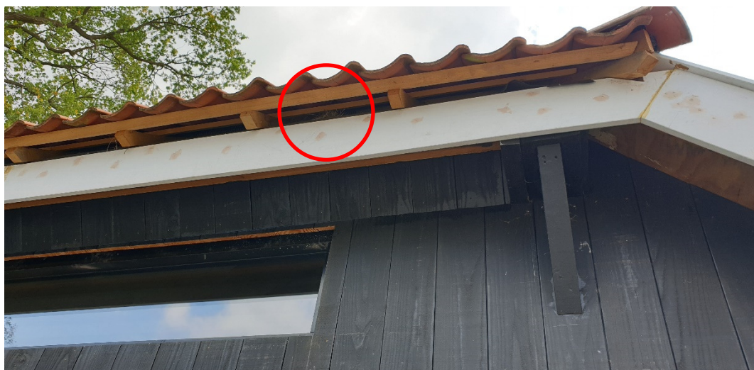
Nieuw dak, nest huismus rood omcirkeld
