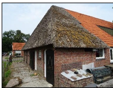
Figuur 4. Schuur, gezien vanaf het westen.
