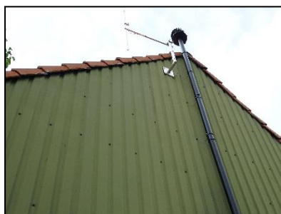
Figuur 6. Detailfoto dak.
