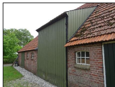
Figuur 5. Schuur gezien vanaf het noordoosten.
