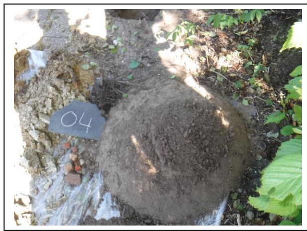
Foto 4. Opgegraven en gezeefd materiaal asbestinspectiegat 04
