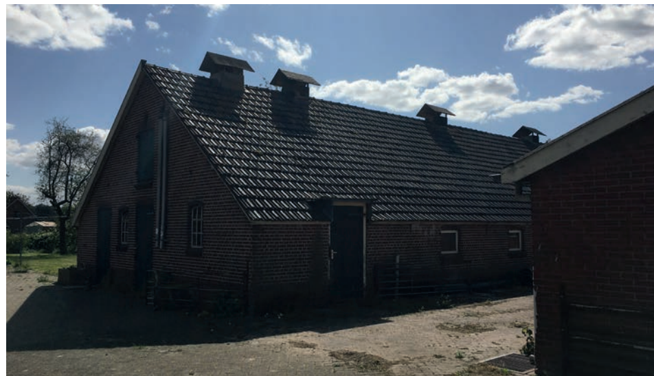
Afbeelding 7. Te slopen schuren
