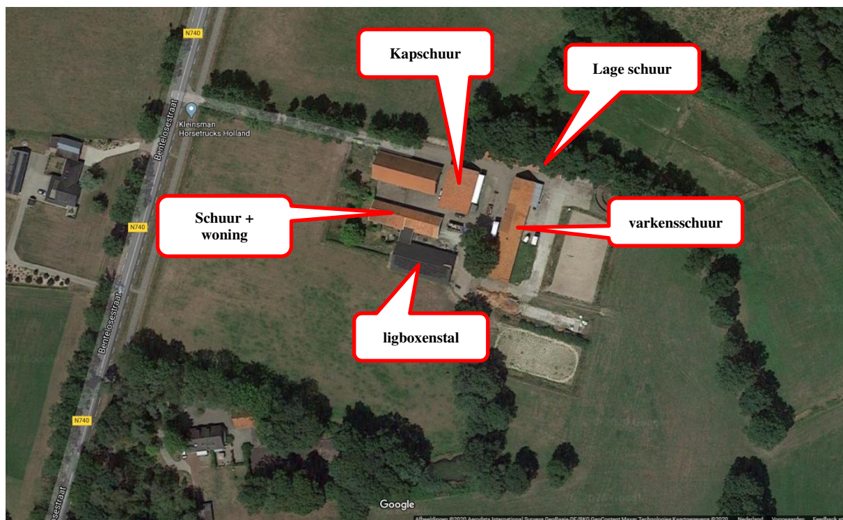
Figuur 1: Situatie Erve Huisveld, in rood de te slopen gebouwen
