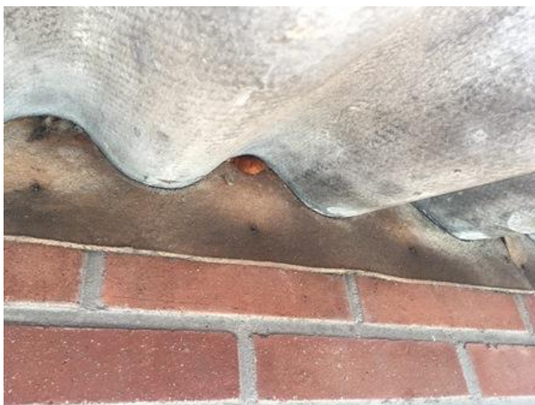
Afgedichte nokken van de golfplaten. Hierdoor kan de steenmarter (of een vogel) geen verblijfplaats bezetten onder de golfplaten.
